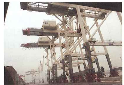
アイランドシティコンテナターミナル、 ガントリークレーンの真下より
