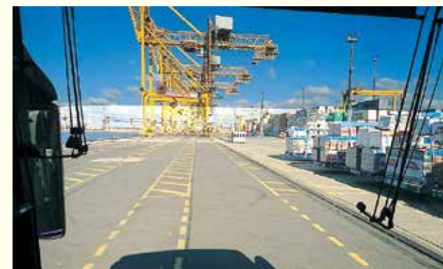
サンクトペテルブルグ港には最新のガントリークレーンが整備されている。
