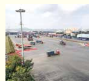
鉄道コンテナヤード
