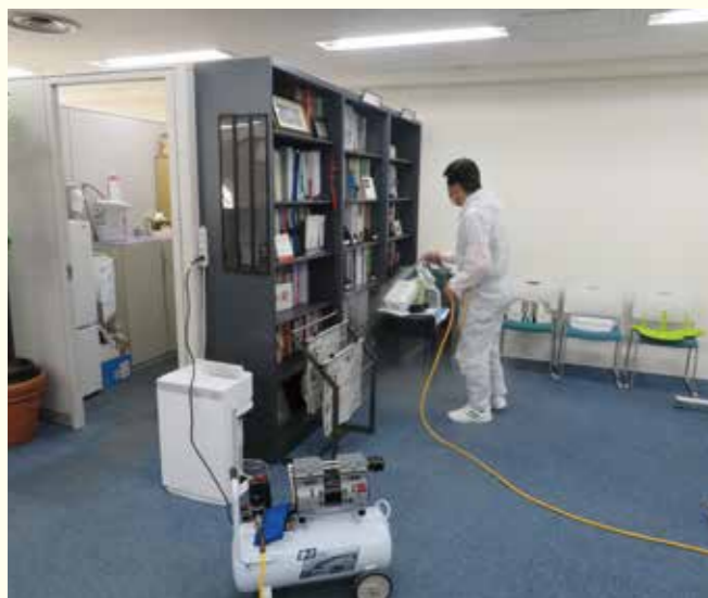
事務所内での施工の様子
